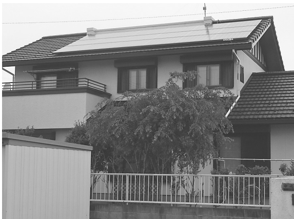
将来、追加できるようにレイアウトされた太陽光パネル
