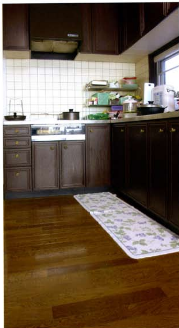
ガスコンロが置かれていた場所にIHクッキングヒーターを設置。 動線などの使い勝手はそのままに、機能的なキッチンになりました。
