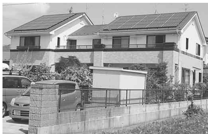
屋根の広さいっぱい設置された太陽光発電パネル
